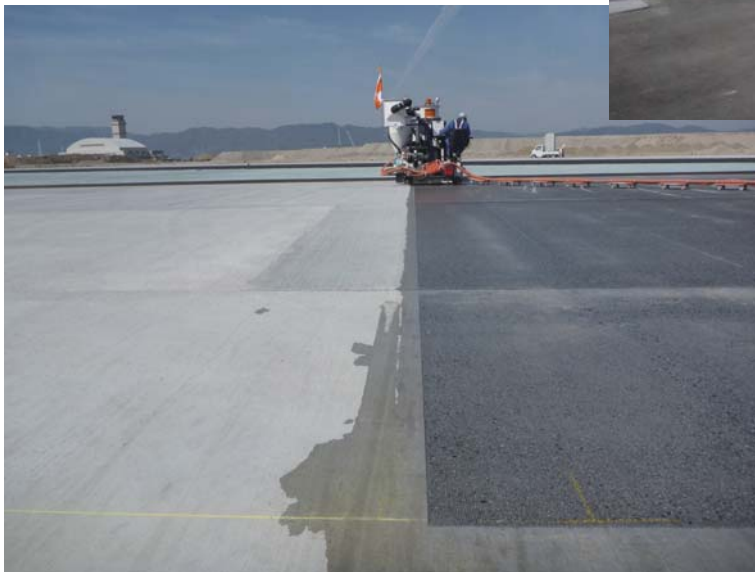
▲グラインダーPC-150Sによる施工状況
