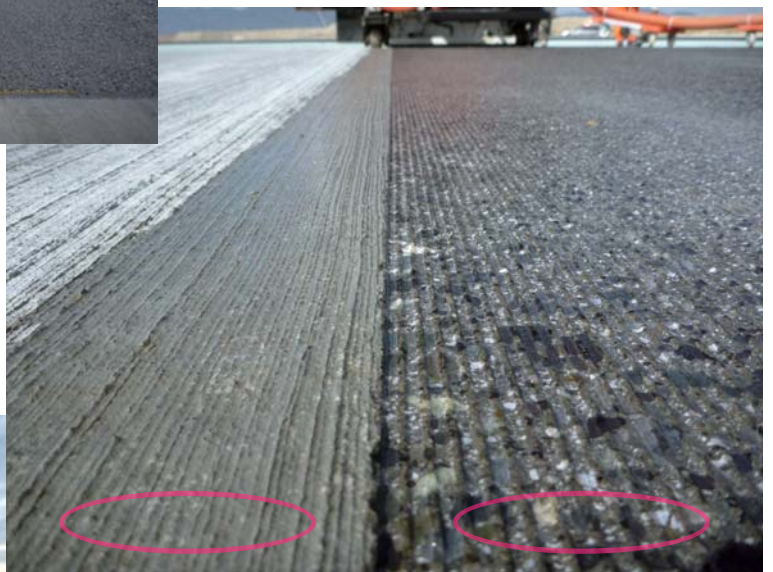
▲人力によるほうき目仕上げ
